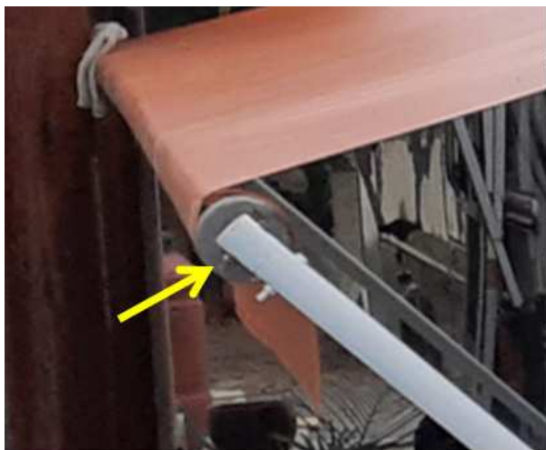
Parafuso-trava do eixo do toldo
